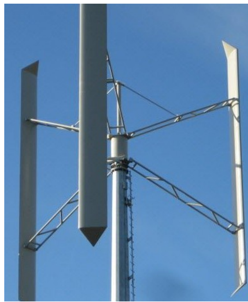
Abb. 1: H-Rotor einer VAWT.
