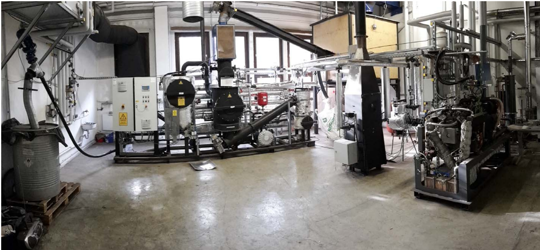
Holzvergasungsanlage mit Motor-Heizkraftwerk
