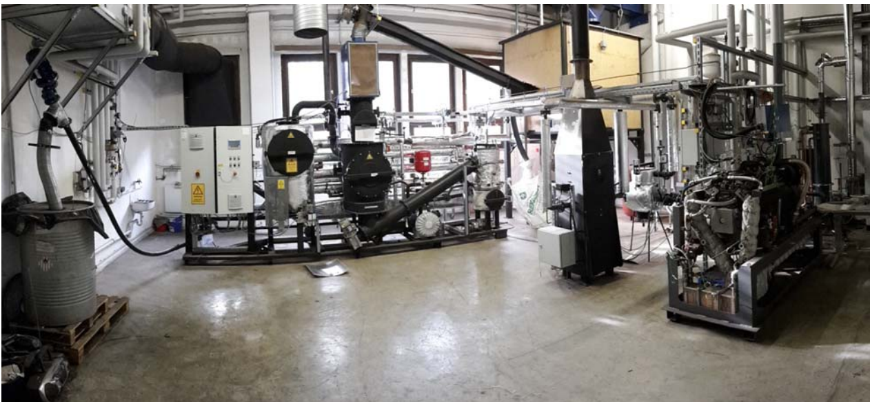
Holzvergasungsanlage mit Motor-Heizkraftwerk
