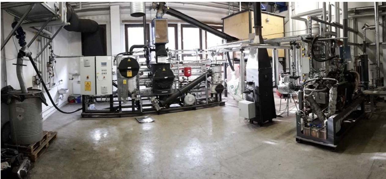
Holzvergasungsanlage mit Motor-Heizkraftwerk
