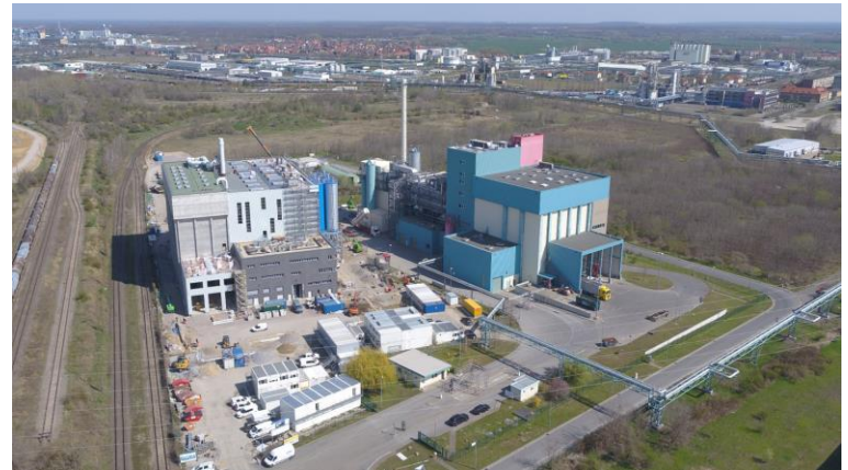
Thermische Restabfallbehandlungsanlage (rechts) und Klärschlammmonverbrennungsanlage (links)
