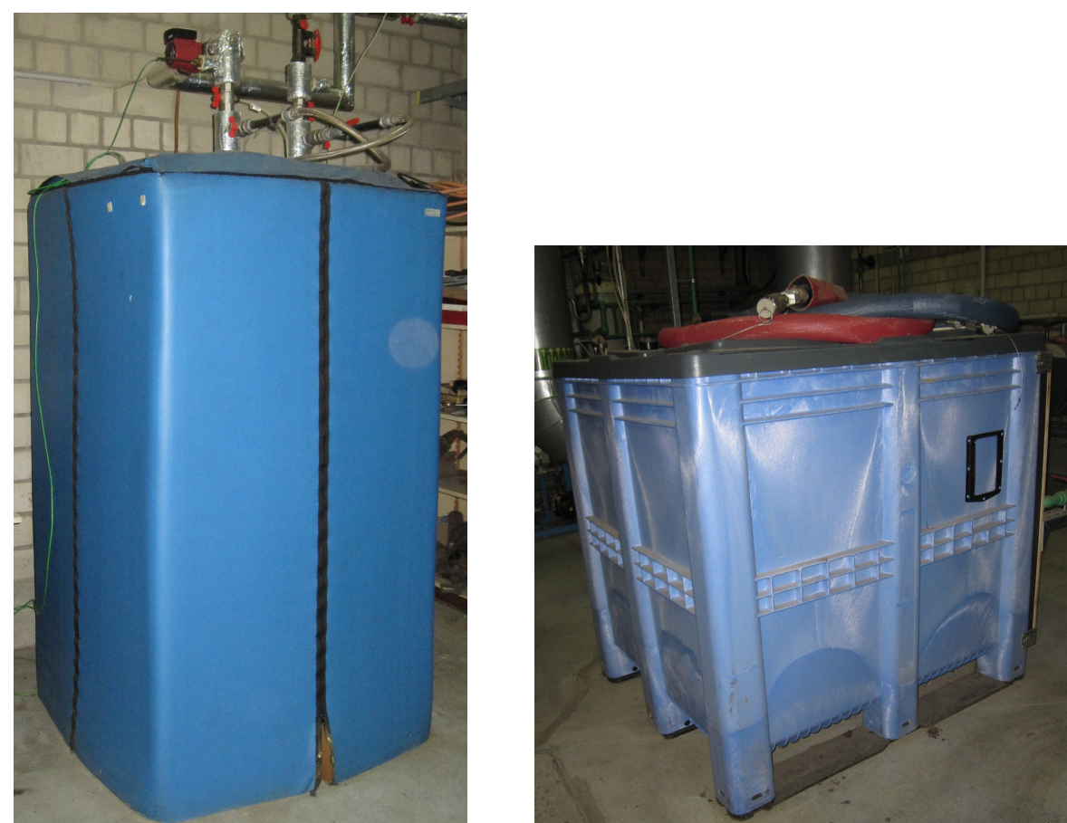
Abbildung 3: Latentwärmespeicher mit Natriumacetat (links) und Alkangemisch (rechts)
