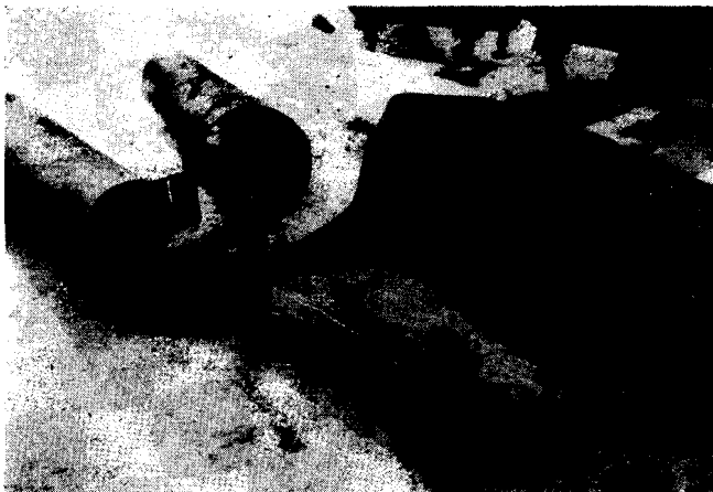
Bild 1. Teilansicht eines aufgerissenen Rohrs aus einer Stichleitung des primären Vorlaufs eines Fernheiznetzes
